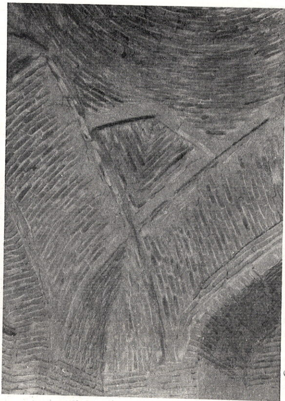
Рис. 33. Парус «тугри-гаджак» в своде на четырех пересекающихся арках в дарвоза-хона усыпальницы кокандских ханов Дахмаи-шошон на кладбище Котта-Кабристон. Коканд. Фото Узкомстариса
