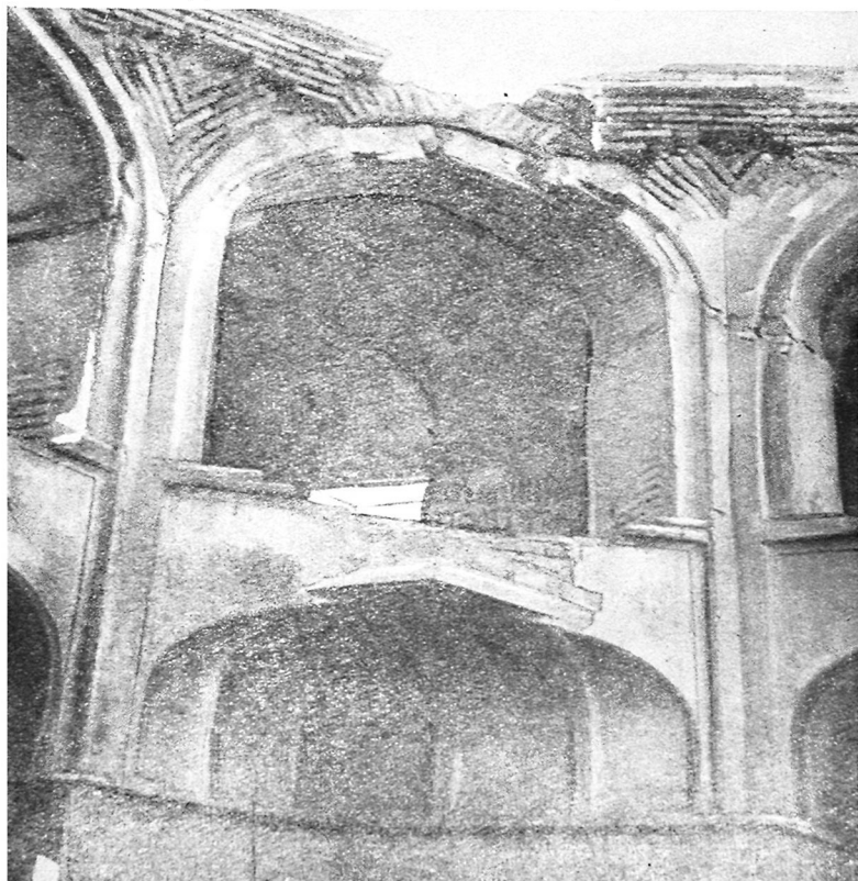
22. Конструкции перекрытий в северо-западной дарехане.
