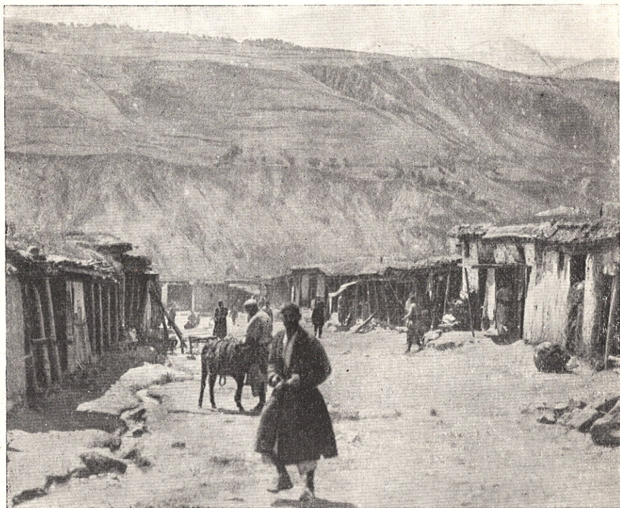
Разрушенный басмачами кишлак.
