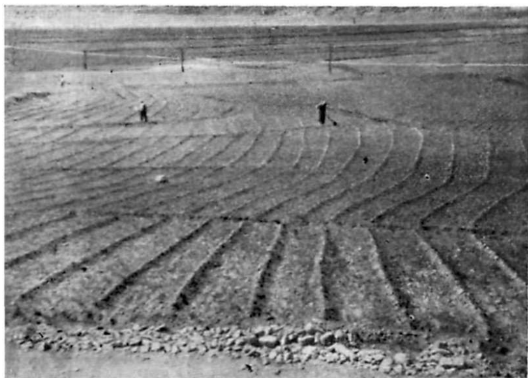
Рис. 5. Поле, подготовленное для орошения валиковым способом
