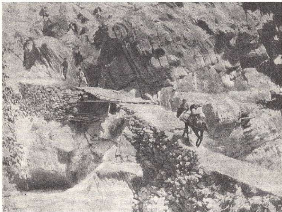
Рис. 4. Мост через р. Язгулем
