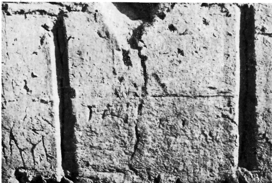
Табл. 9. Кафыркала. Пахсовая стена, прорезанная швами
