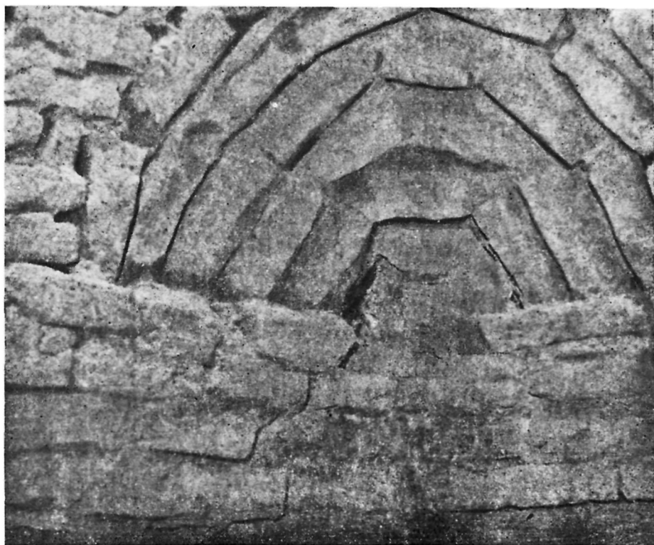
Табл. 12. Кафыркала. Цитадель. Тромп в помещении I
