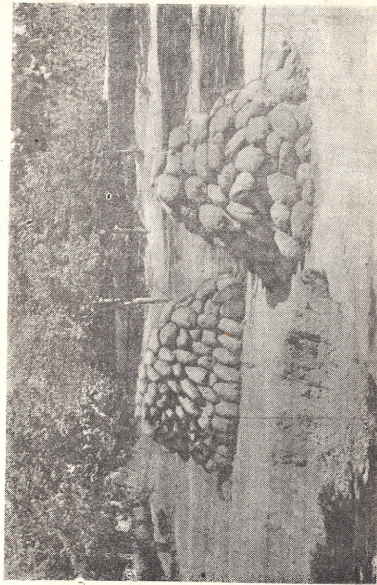
Рис. 3. Сложенные в кучу «гуала» — сыровые, формованные руками комки глины, заготовленные для кладки стен, кишл, Костаноз.
