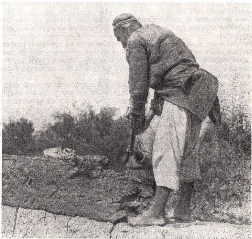
Рис. 22. Кладка пахсовой стены
