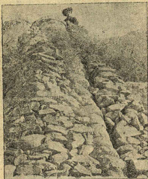
Водонапорная труба нохурской мельницы (составлена из ряда наложенных одно на другое больших каменных колец). (Фото Н. Фатгаха)
