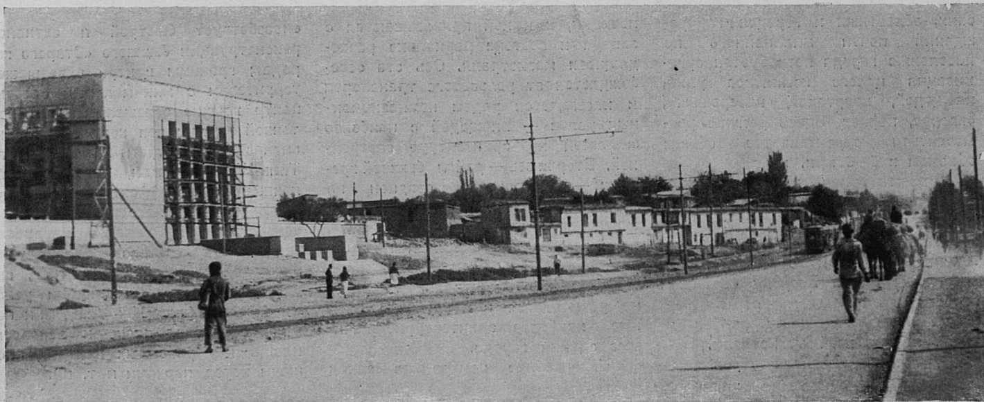
Ташкент. Строящееся здание кинотеатра на ул. Наваи
