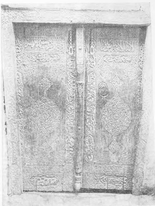
Рис. 5. Двери в медресе Алла-кули-хан типа нарвал-капу, черного цвета из вяза, 1,7×1,35 м с двумя медальонами turudz и арабскими надписями в орнаменте
