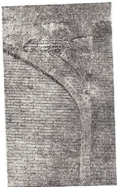
Построение арок на фасаде м. Калон (XVI в.): фотография двух арок, расчищенных на западном фасаде мечети; построение арок двух типов («лингга тез» и «лингга шалгами»).
