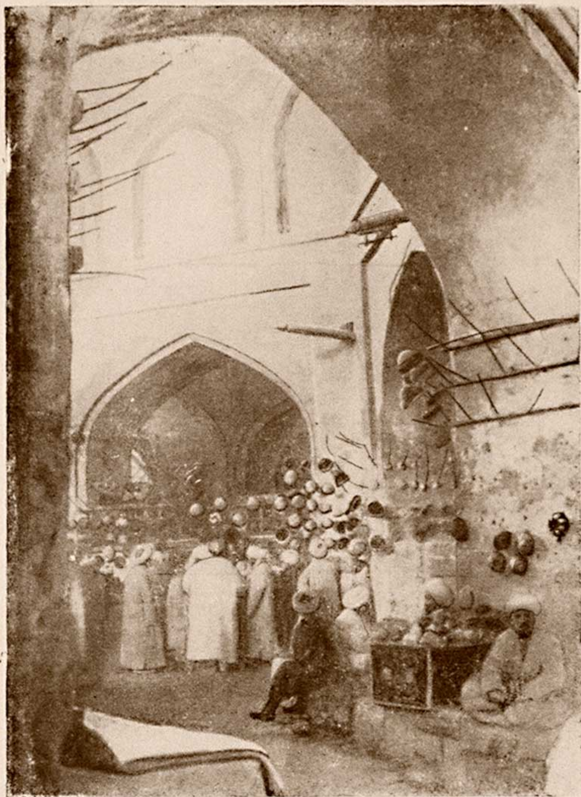
Рис. 18. Бухара. Пассаж Токи Тельпак (внутренний вид)
