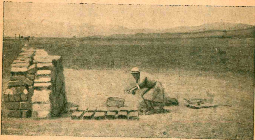
Сталинский район, сельсовет Западнококчорский, в долине реки Восточный Каракол. Колхоз им. К. Маркса. Заготовка сырцового кирпича для строительства жилого дома колхозника
