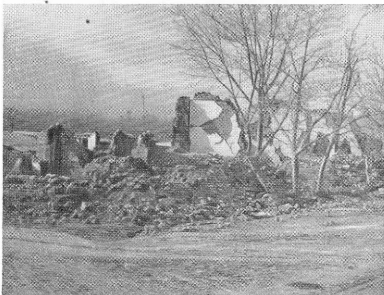
Рис. 213. Разрушения сырцовых домиков в поселке Геок-Тепе
