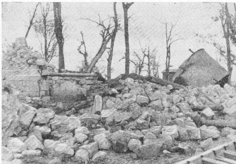
Рис. 212. Разрушение каменной водонапорной башни
