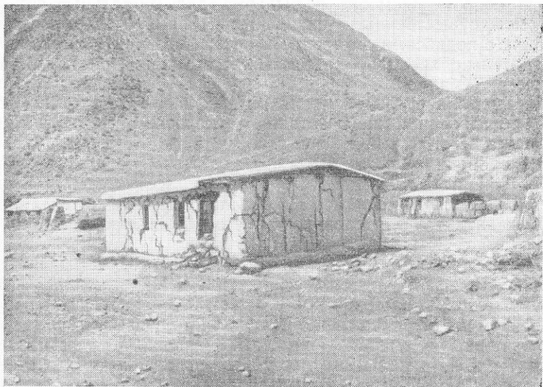
Рис. 11. Жилой дом из сырцового кирпича среднеазиатского типа, частично разрушенный во время Кемино-Чуйского землетрясения
