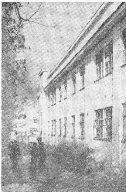
Рис. 249. Административные здания с деревянными каркасными стенами и фибролитовым заполнением
