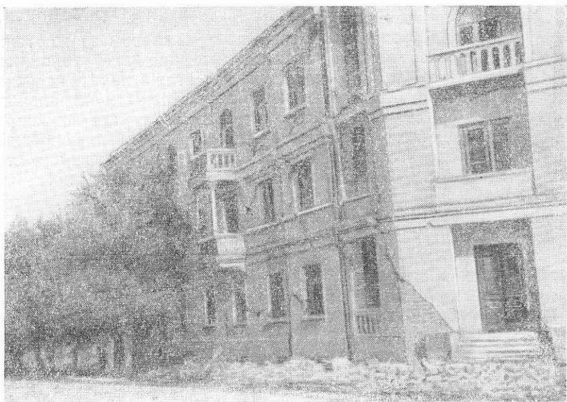
Рис. 38. Вид дома со стороны Кушкинской
