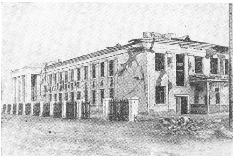
Рис. 216. Школа со стороны главного фасада после землетрясения
