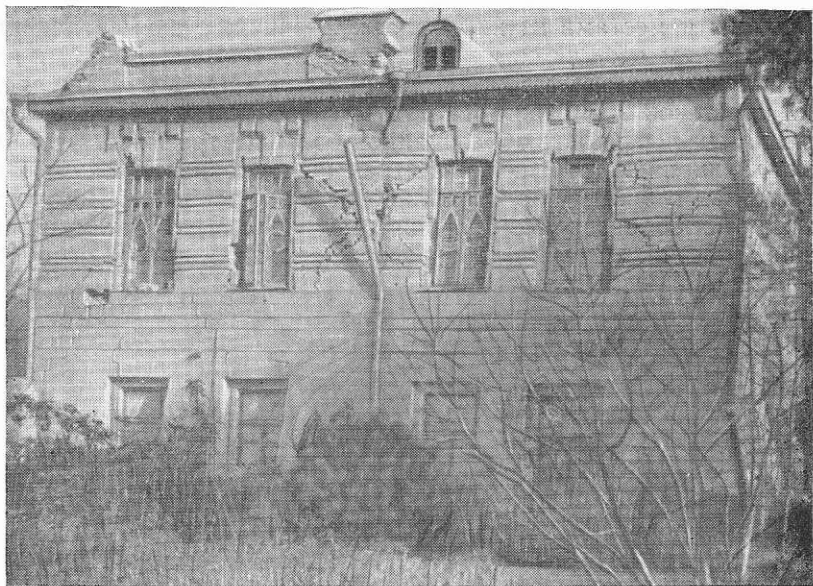
Рис. 125. Разрушение широких простенков в местах примыкания внутренних стен
