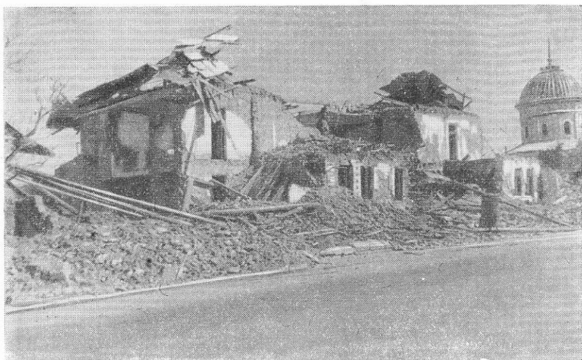
Рис. 119. Разрушения здания республиканского Управления милиции
