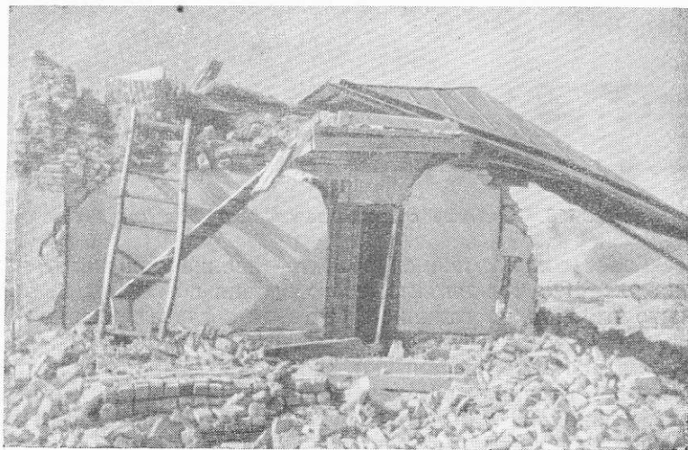
Рис. 187. Смещение крыши бани
