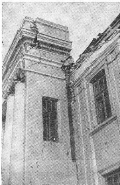
Рис. 69. Обрушение парапетов с карнизами со стороны главного фасада
