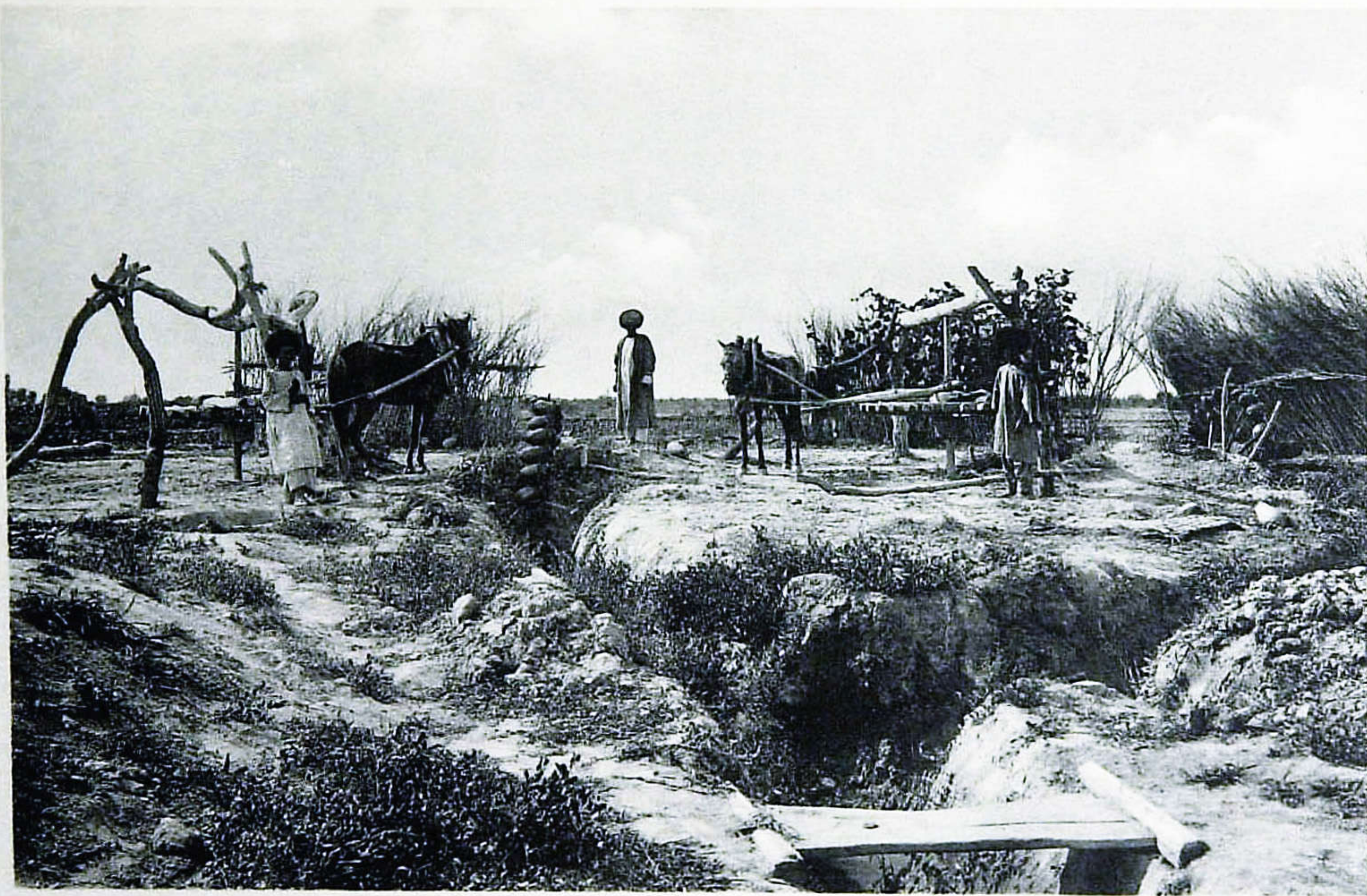
23. Двойной чигирь. Работа на лошадях (Чимбайс. вол.).
