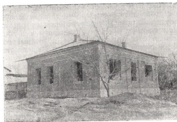
Рис. 5. Строительство жилого дома по типовому проекту.
