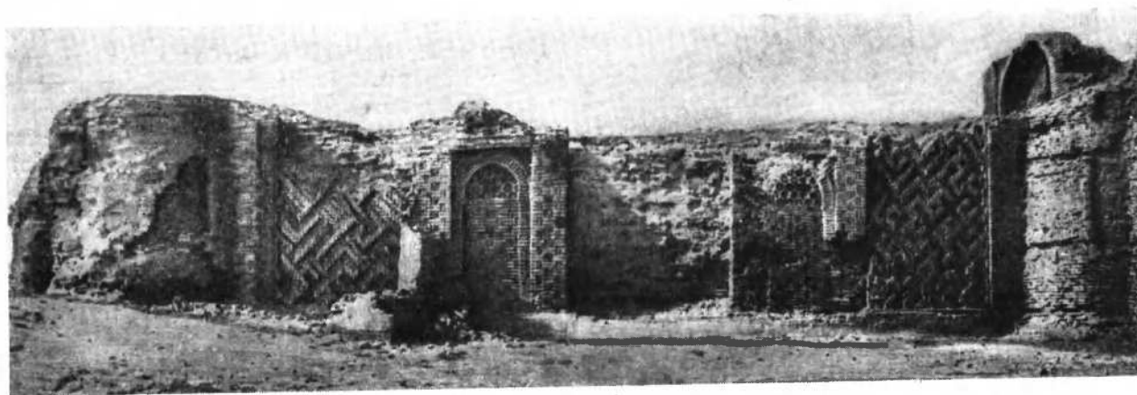
Рис. 16. Левое крыло главного фасада
