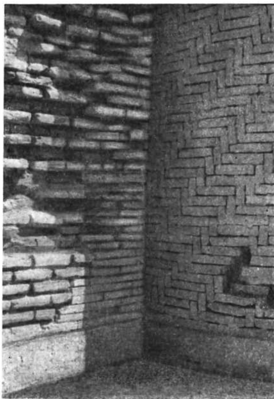
Рис. 24. Деталь кладки пилона портала
