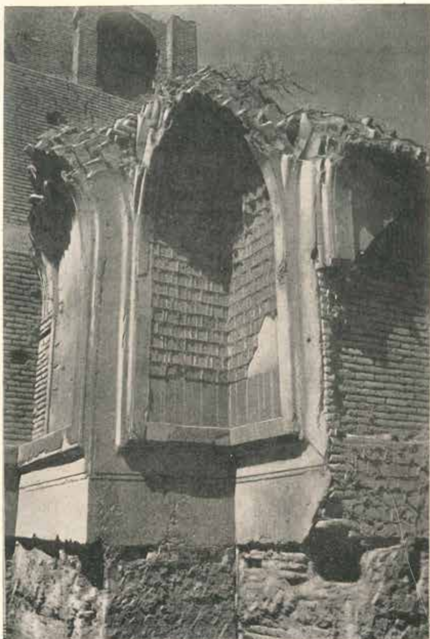
Рис. 20. Угловые паруса центрального зала.
