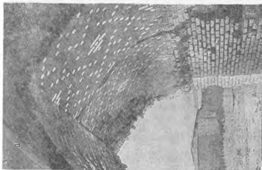
Рис. 5. Разрезные швы и обкладки софитов боковых проходов Большой мечети: а — северный проход, б — южный проход.
