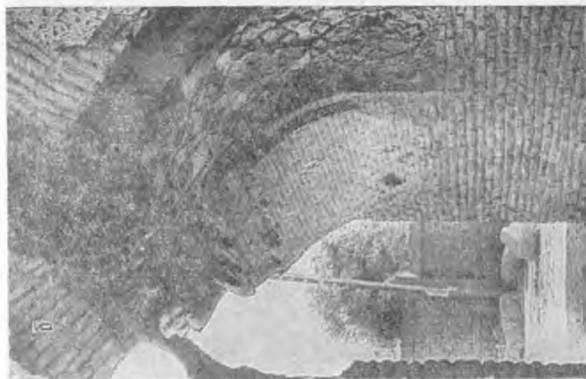
Рис. 5. Разрезные швы и обкладки софитов боковых проходов Большой мечети: а — северный проход, б — южный проход.
