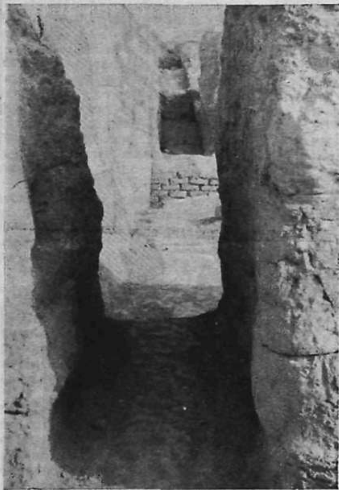
Рис. 30. Дт-6. Боков. проход в зале из обводного коридора.
