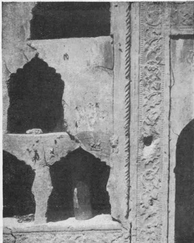
Каркасная стена с вдавленным при помощи штампа орнаментом
