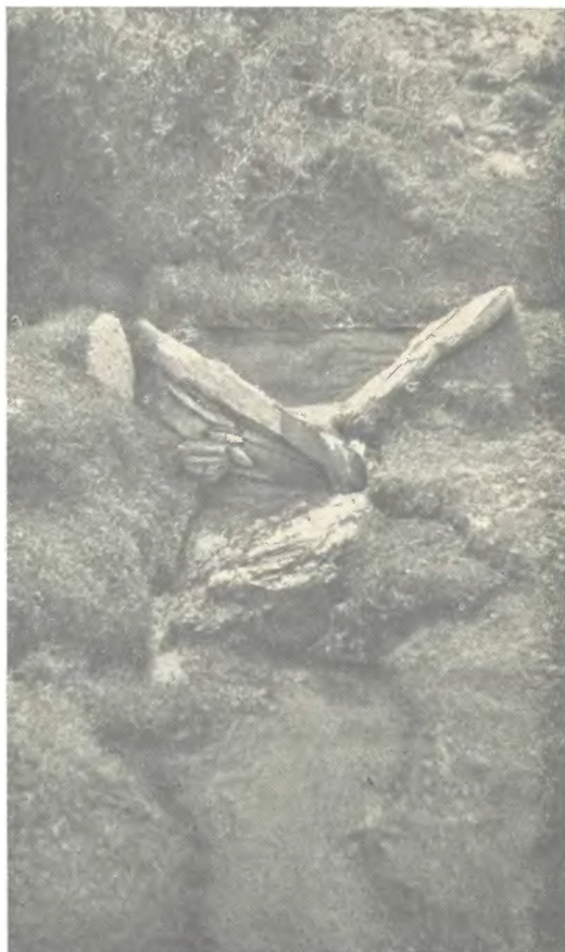
РИС. 4. Каменный водослив на Памире (фото Б. В. Андрианова)
