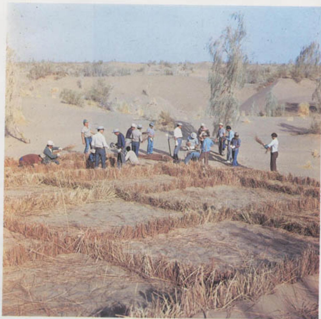
Практические занятия по устройству клеточных защит для слушателей международных курсов СССР ЮНЕП по борьбе с опустыниванием
