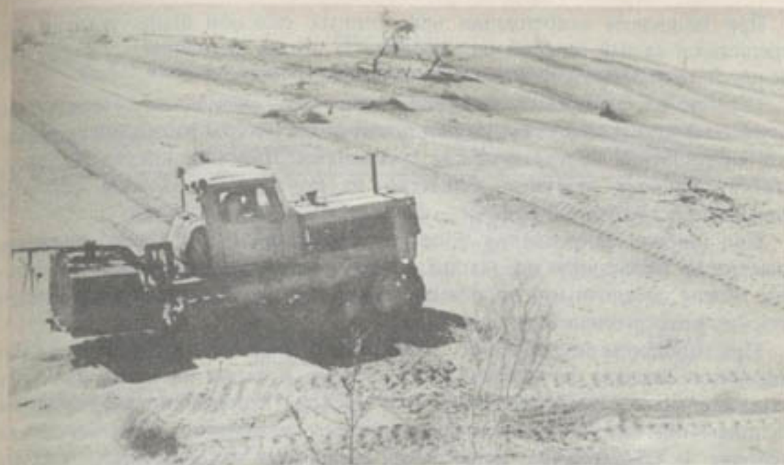
Рис. 19. Нанесение вяжущих веществ на песчаную поверхность.
