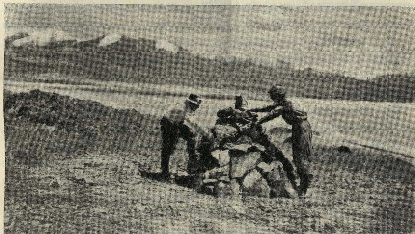
Восстановление триангуляционного знака на Каракульском острове.
