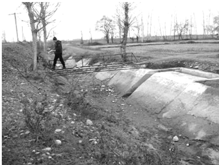
Рис.1. Гидрометрический пост типа «фиксированное русло»
