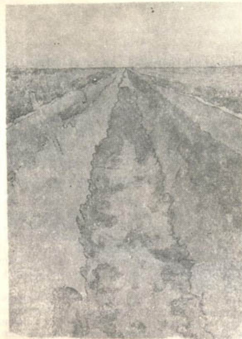
Рис. 3. Заиление лотков-каналов.
