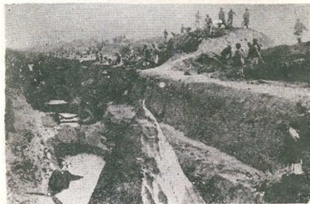
Рис. 1. Строительство канала вручную.
