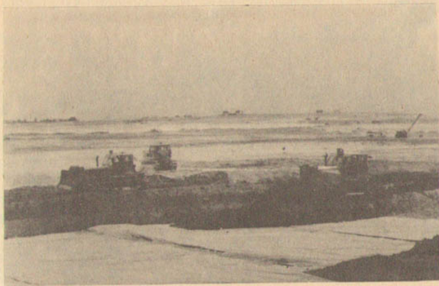
Укладка пленки в чашу Базар-Коргонского водохранилища.
