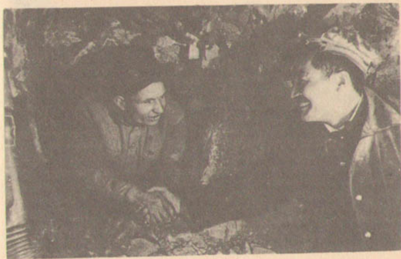
Торжественный момент: сбойка Ортокойского тоннеля. Проходчики Жиндигов и Молдыбаев.
