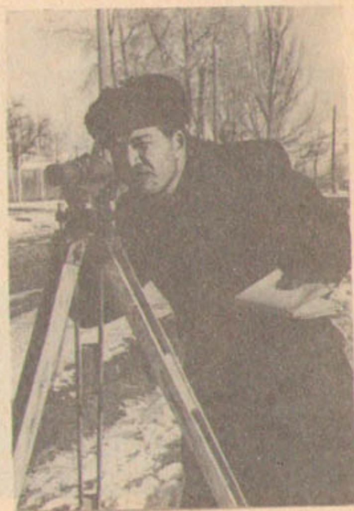
На изысканиях под сельский водопровод.
