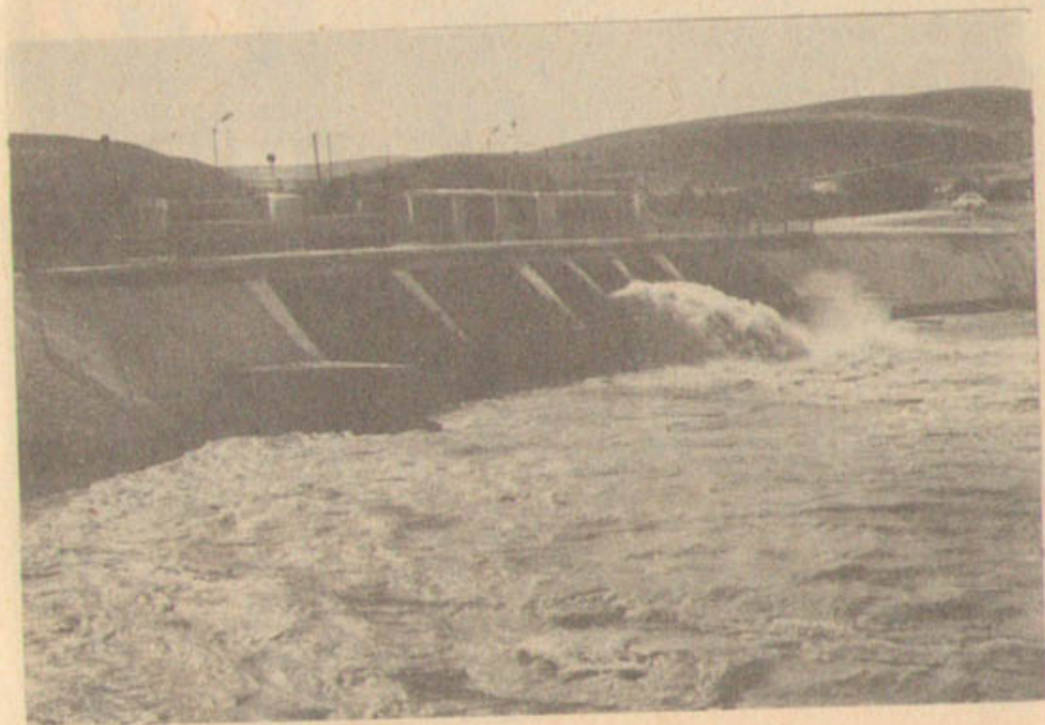
Караункюрская плотина с нижнего бьефа.
