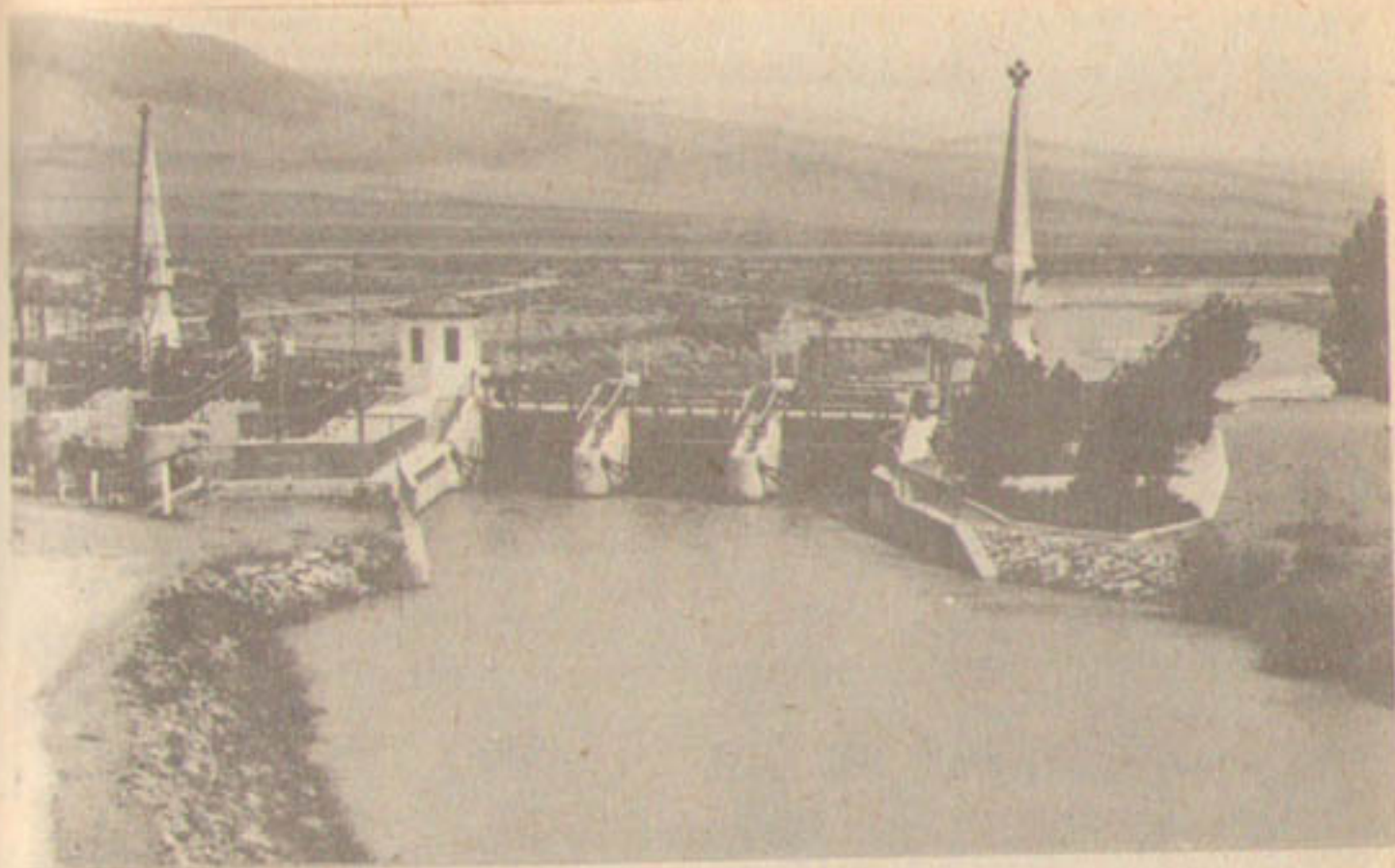
Плотина на р. Чу в голове ЗБЧК.
