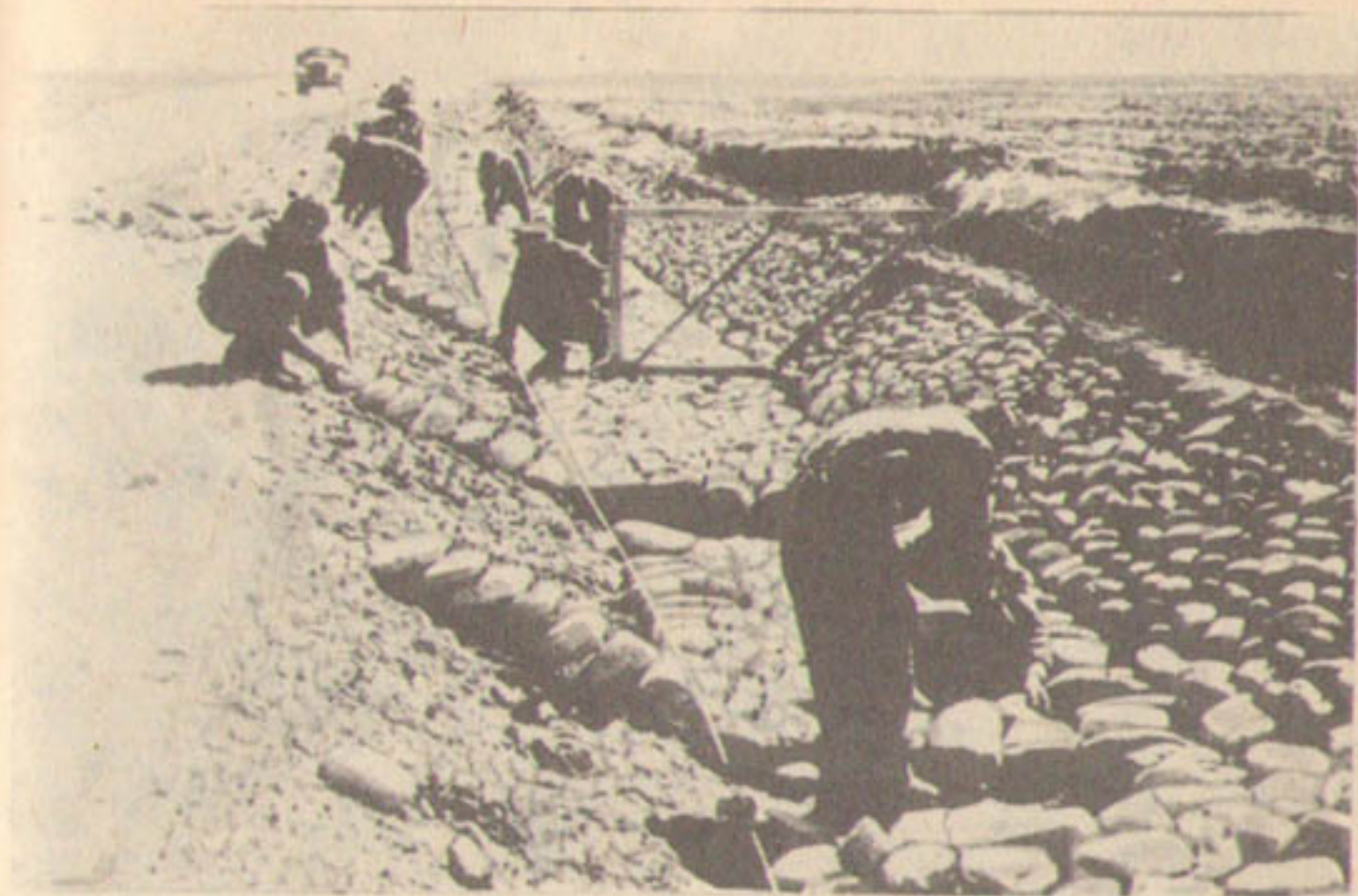
Канал Суусамырский. Процесс мощения.
