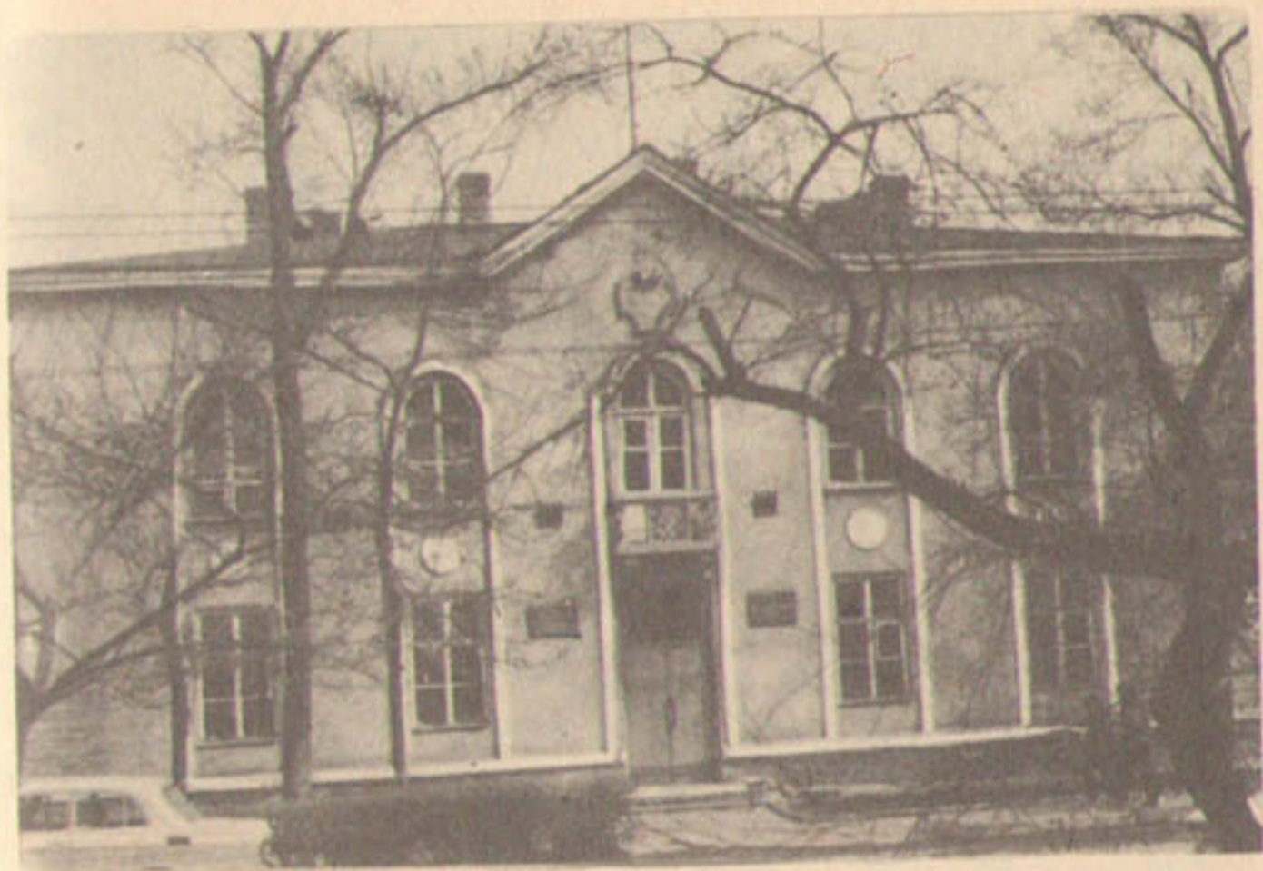
Административное здание Ортокой БЧКстрой по ул. Московской.
