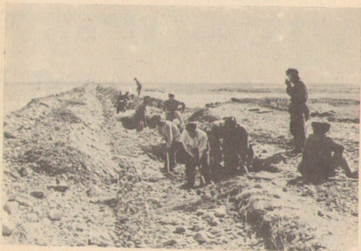
Канал Суусамырский. Подготовка земляного русла.
