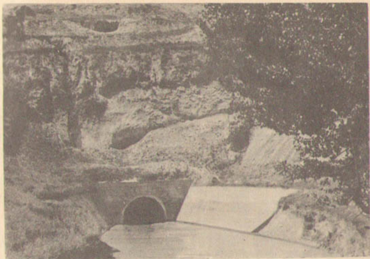
Тоннель на канале Огуз-Амра
