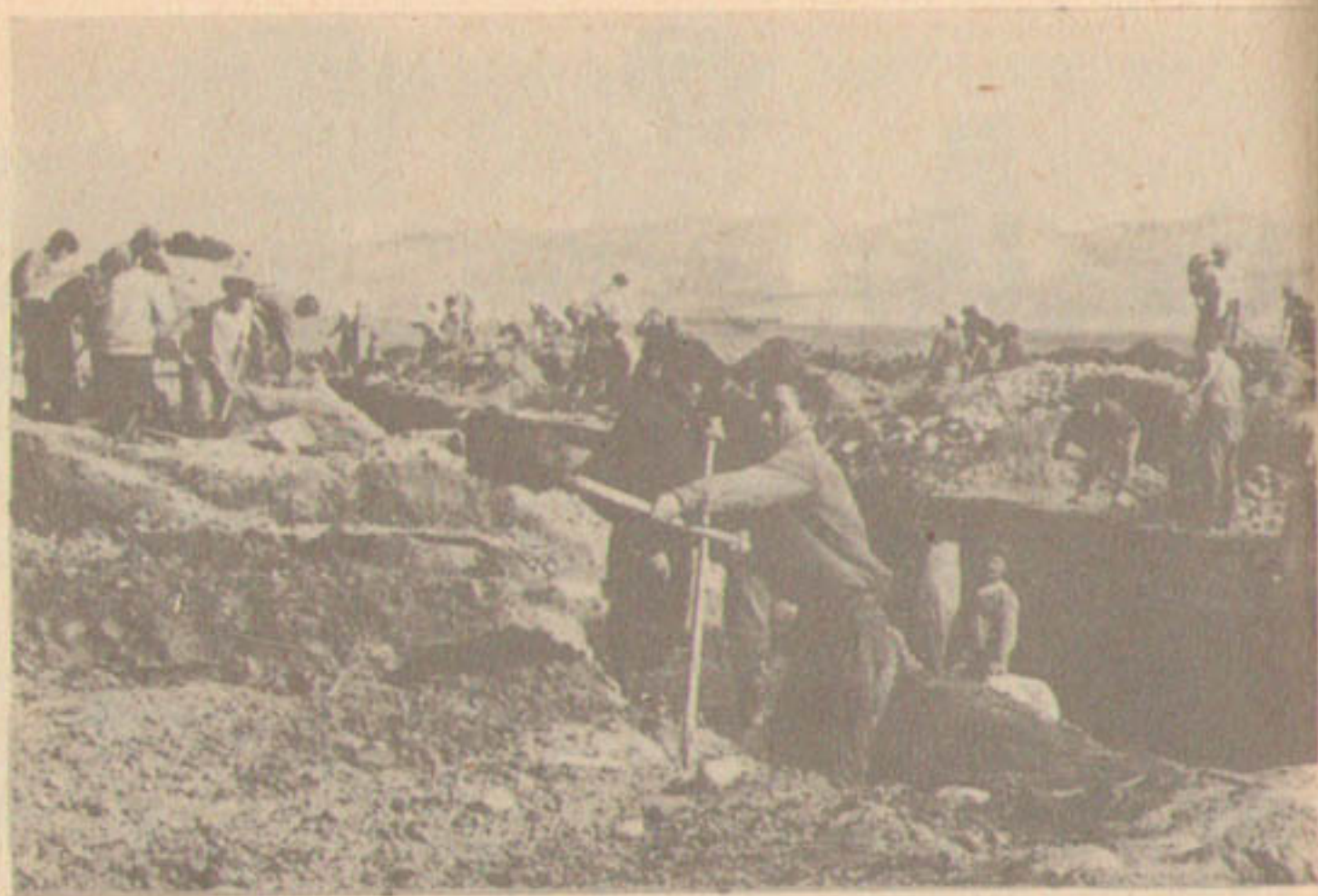
На строительстве Восточного БЧК.
