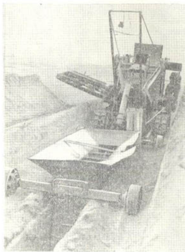
Рис. 3. Дренопрокладчик Д-251 в работе.
