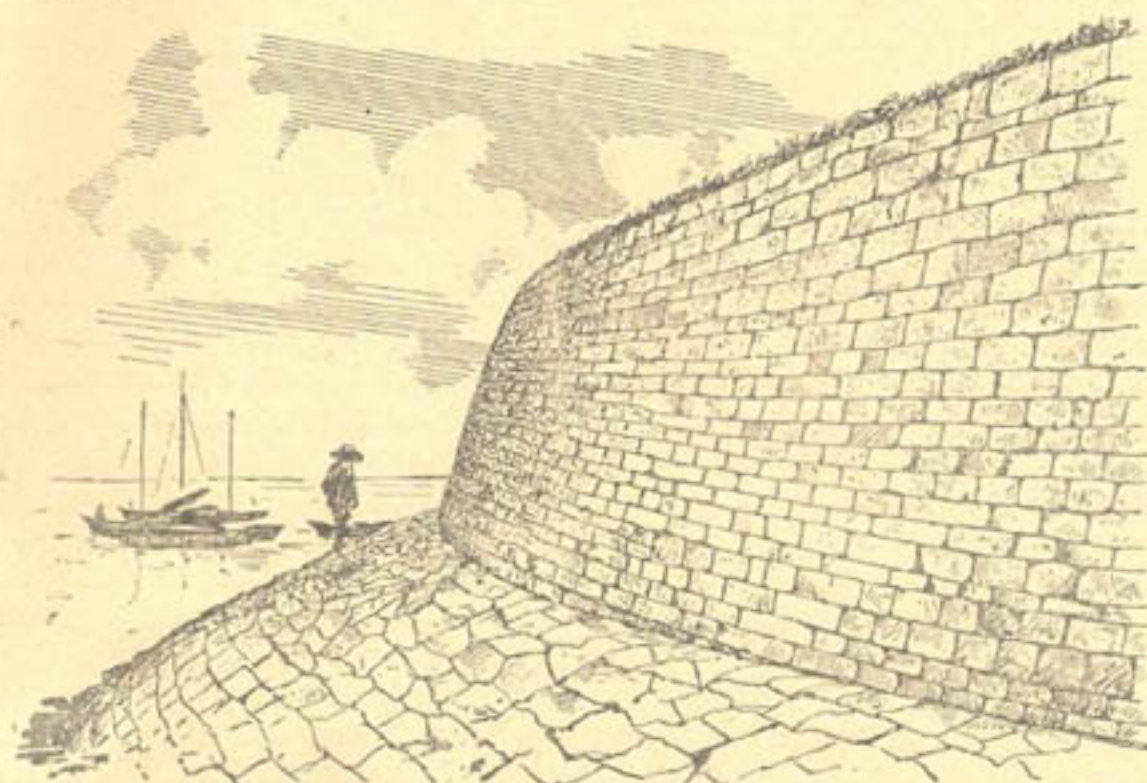
Рис. 2. Крепление откоса защитной шпоры.
