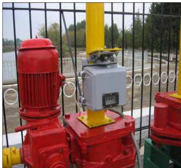
Рис. 6. Установка ДПЗ на винт затвора
