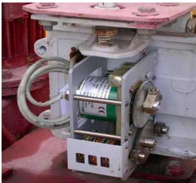
Рис. 5. Датчик положения затвора (ДПЗ)
