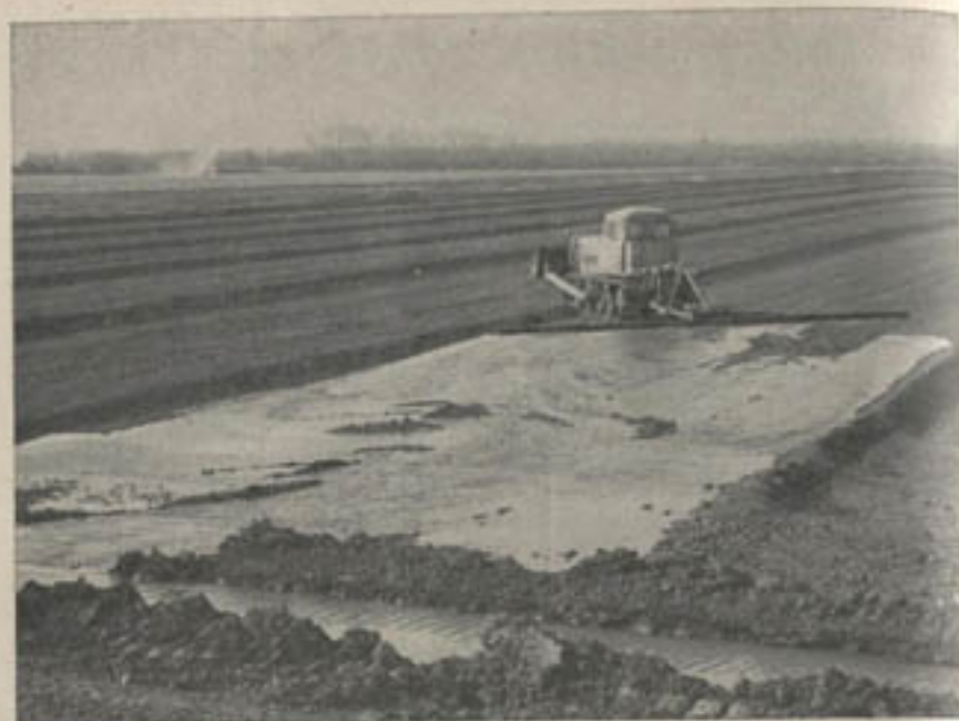
Рис. 25. Влаговарядка с помощью бульдозера.
