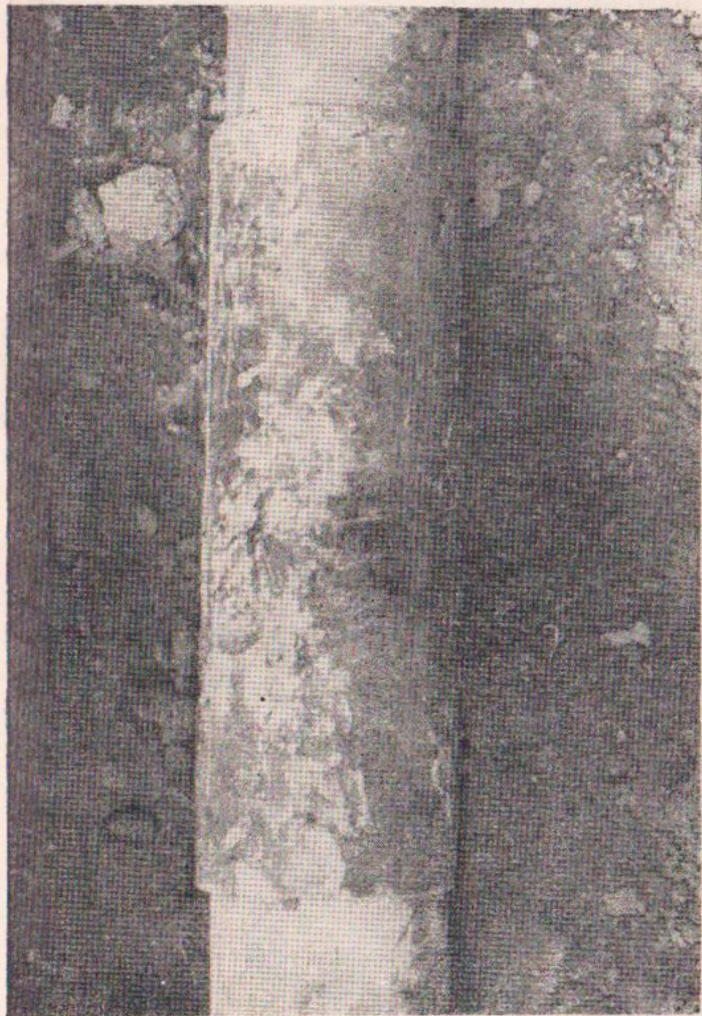
Рис. 28. Узел соединения вертикальной дрены с собирателем.
