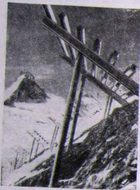
Рис. 21. Сборные металлические снегоудерживающие щиты (Швейцария)
