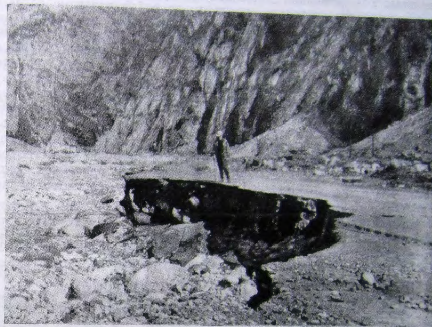
Рис. 32. Поврежденное селем полотно дороги
