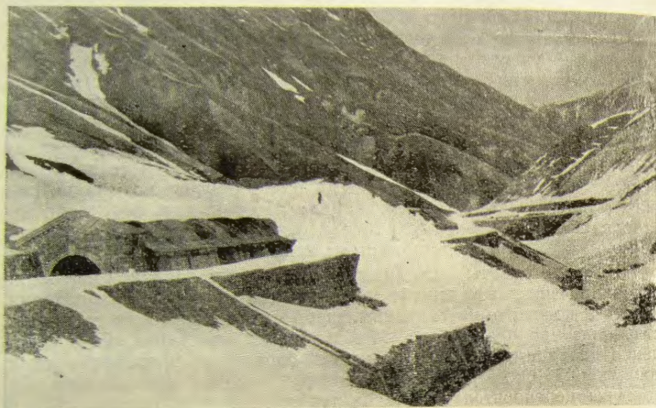
Рис. 16. Противолавинная галерея, засыпанная лавиной
