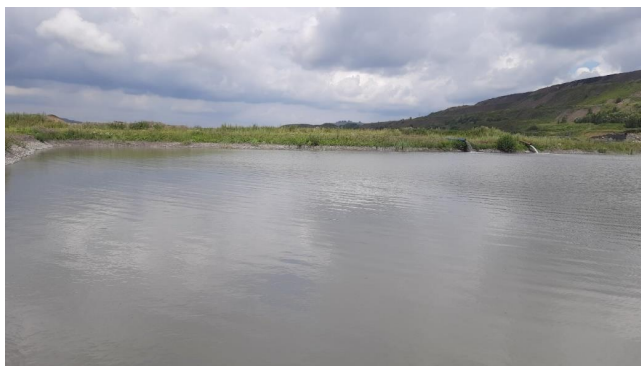
Рис. 1. Общий вид приемного резервуара очистных сооружений
