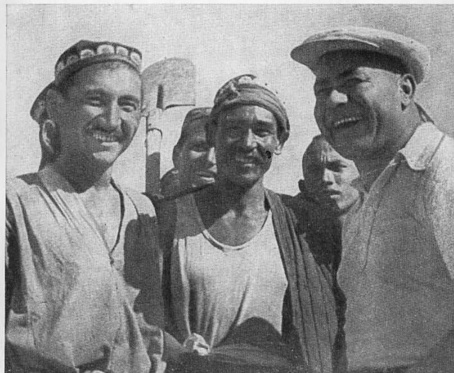
Строители Большого Ферганского. 1939 г.
