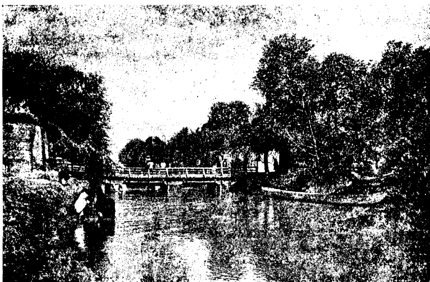
Инженерно-иригационная система „Шурахан“.
