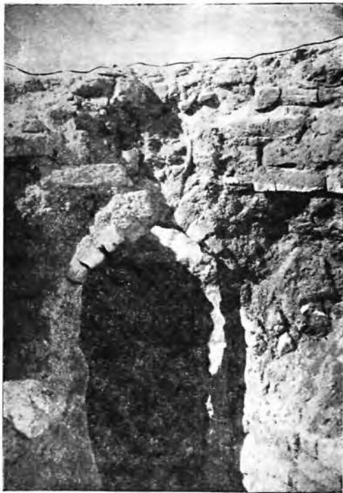
Рис. 13. Топочное устье печи раскопа № 3.
