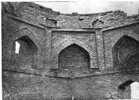
Рис. 61. Гёк-гумбез. Тромпы мавзолея № 3.
