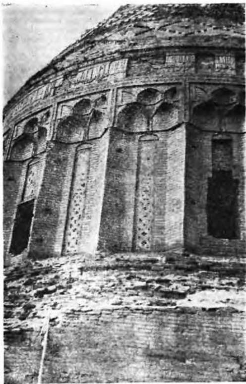
Рис. 49. Мавзолей Текеша. Детали облицовки барабана.
