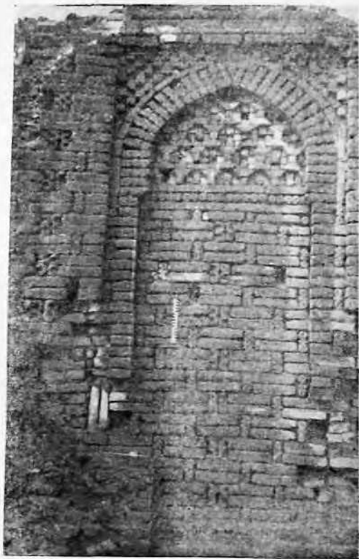
Рис. 33. Дая-Хатын. Выкладка резным кирпичом на главном фасаде.
