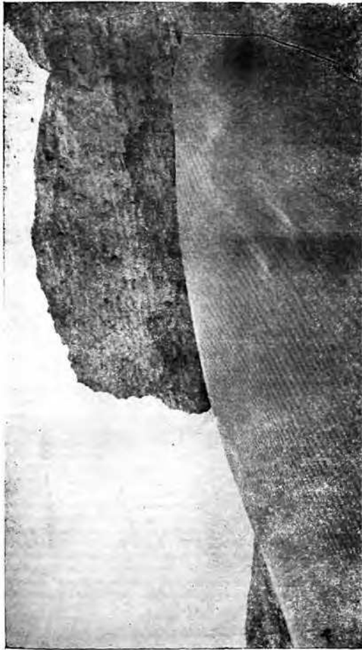
Рис. 40. Куля-Ургенч. Крепость Ак-кала. Разрушение сырцового кирпича под влиянием ветра и влаги.
