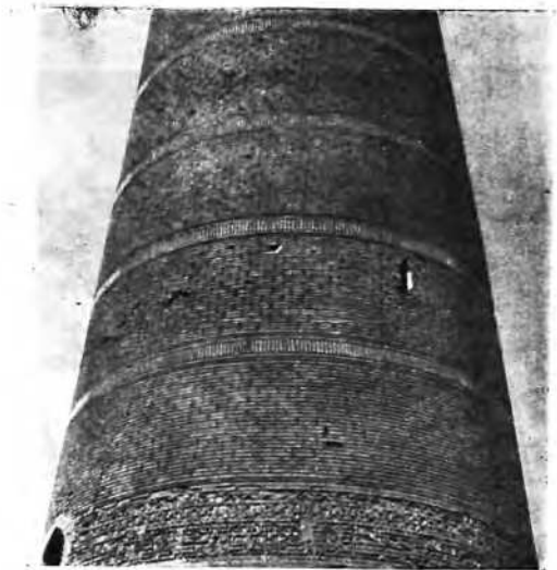
Рис. 54. Куня-Ургенч. Минарет XIV в. Детали облицовки шлифованным кирпичом. Внизу, слева—вход в минарет и лента надписи, скрепленной гипсовым раствором.
