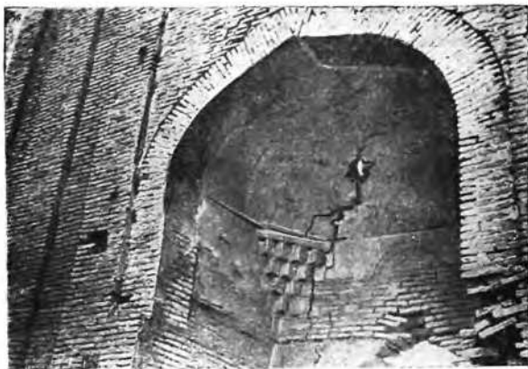
Рис. 62. Гёк-гумбес. Консольно-ячеистые паруса portalной ниши мавзолея № 3.
