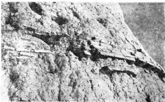
Рис. 1. Облицовка пахсовой башни сырцовым кирпичом. Городище Дарган—близ станции Дарган-ата.
