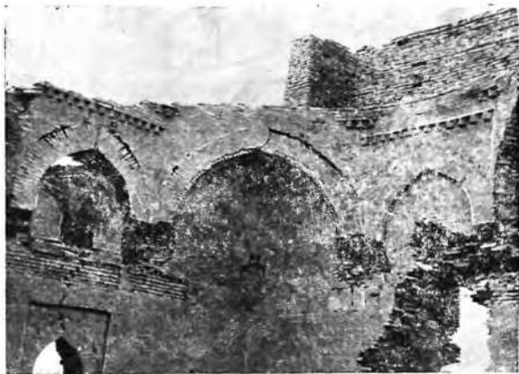
Рис. 60. Гёк-гумбез. Тромпы мавзолея № 2.
