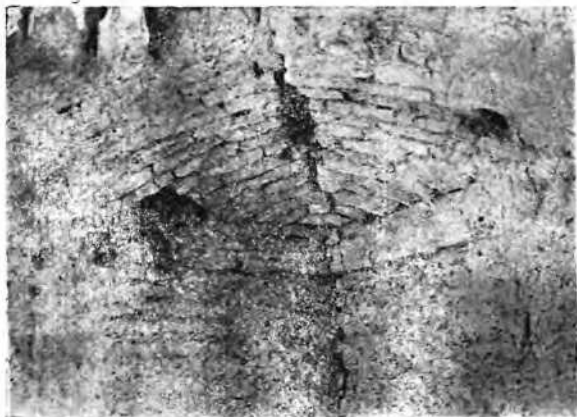
Рис. 33. Смычковый свод бахчи (дом и квартал средневековых керамистов Мерва) — ревязь кладки. Выведение свода бескружальное (в отличие от европейских сомкнутых сводов, которые выводятся с помощью кружал), местонахождение точек кривизны определяется натяжением по диагонали бечевки, закрепленных в противоположном углу.
