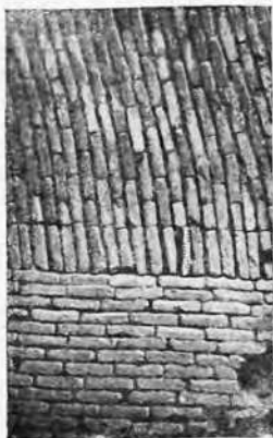
Рис. 35. Дая-Хатын. Кладка стены и свода продолговатой комнаты.
