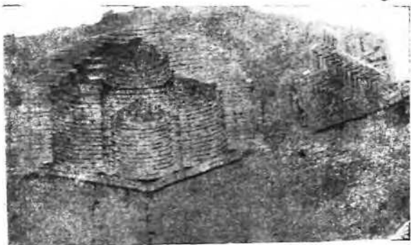
Рис. 47а. Ярты-гумбез, парус без штукатурки.
