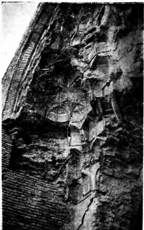
Рис. 50. Сталактиты, выполненные из кирпича, в арке входа мавзолея Текеша.
