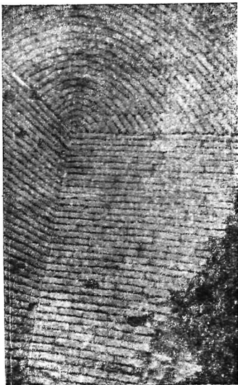
Рис. 34. Дая-Хатын. Кладка угла свода в одной из комнат.
