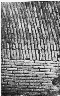
Рис. 35. Дая-Хатын. Кладка стены и свода продолговатой комнаты.
