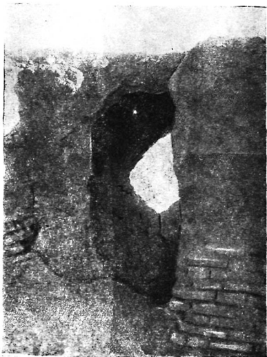
5. Вход в подовую часть печи № 4.
