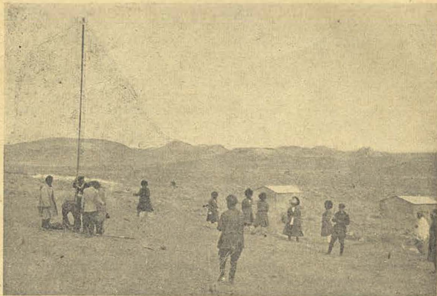
На серном заводе—устанавливается радио-мачта. Фот. А. Ферсмана 1929 г.
