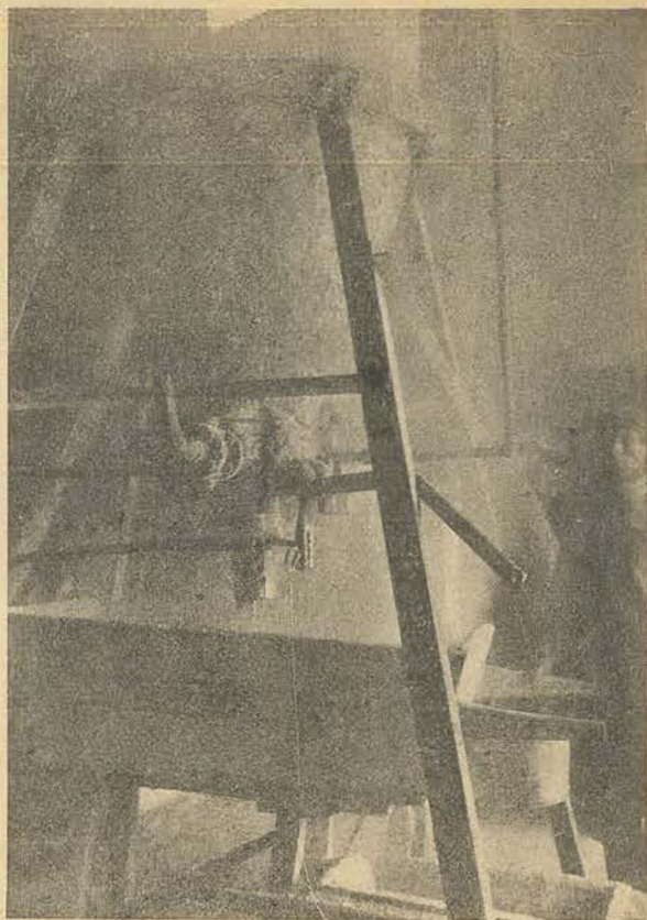
Вид нижней части автоклава в момент выпуска расплавленной серы в деревянное корыто. Снимок П. Волкова в октябре 1928 года.
