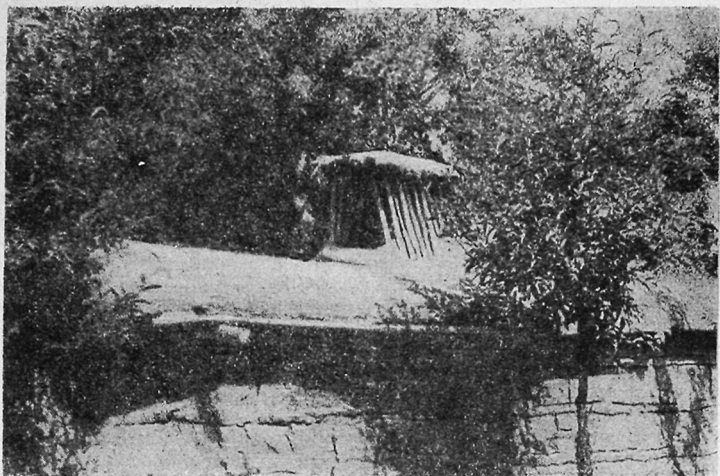
Рис. 2. Козырек — харпуштак на крыше дома над очагом и часть глинобитной стены с прослойками — мойра , к. Нушори-Поён, Гармского района, 1957 г.
