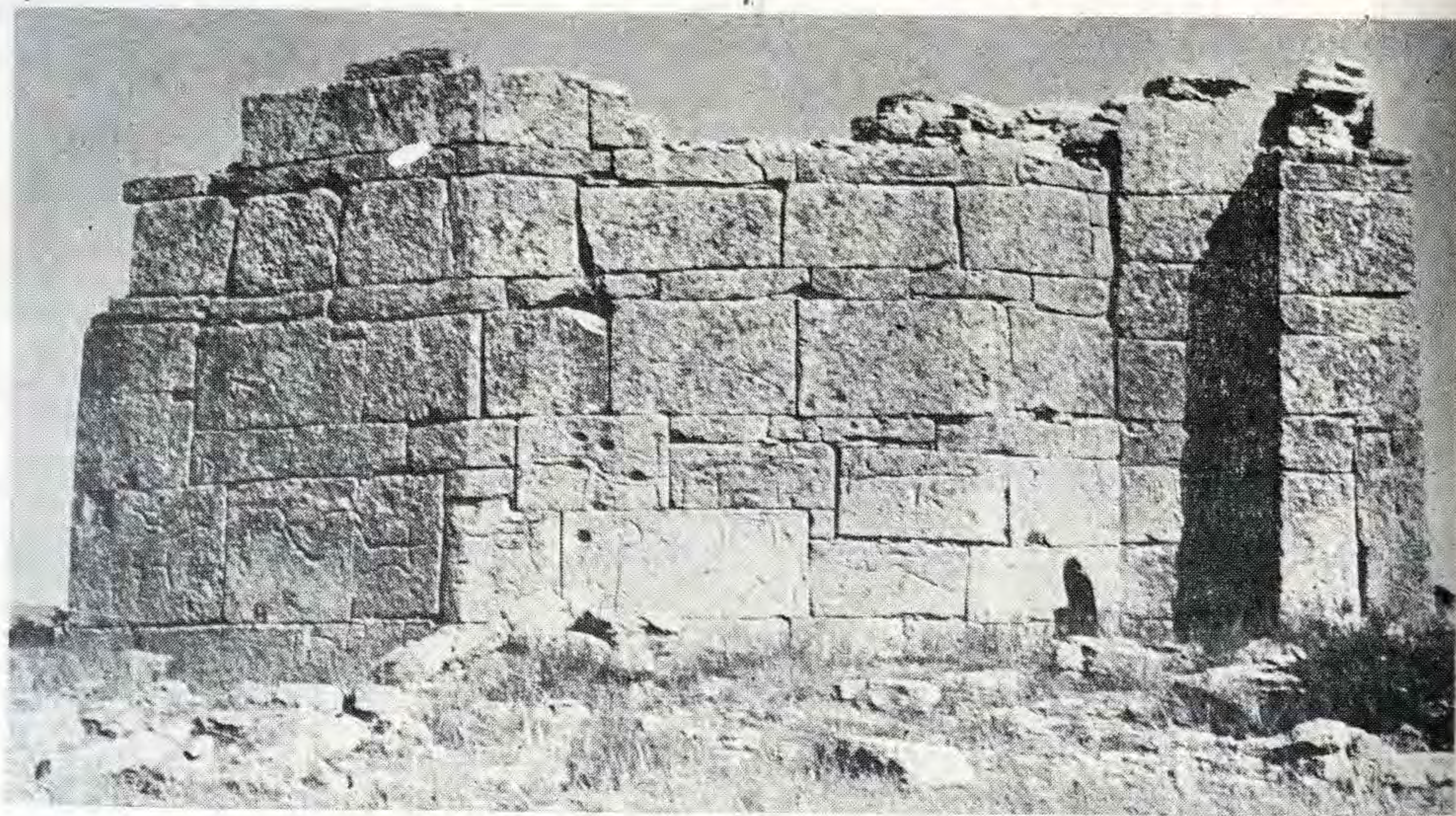
Мавзолей Космола. Западный фасад
