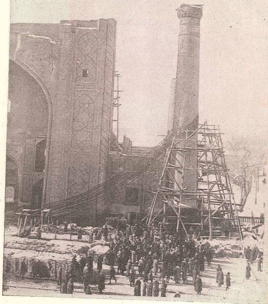
1932 год. Фото снято тотчас после установки минарета медресе Улугбека в вертикальном положении.
