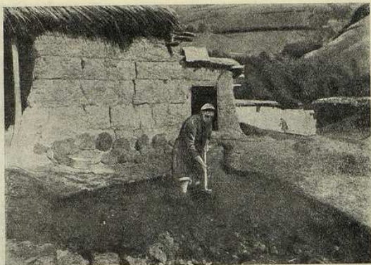
Рис. 3. Ремонт обвалившейся стены. Тип стены, сложенной из лёсса. Гармский район. (Фото С. Абрамзона.)
