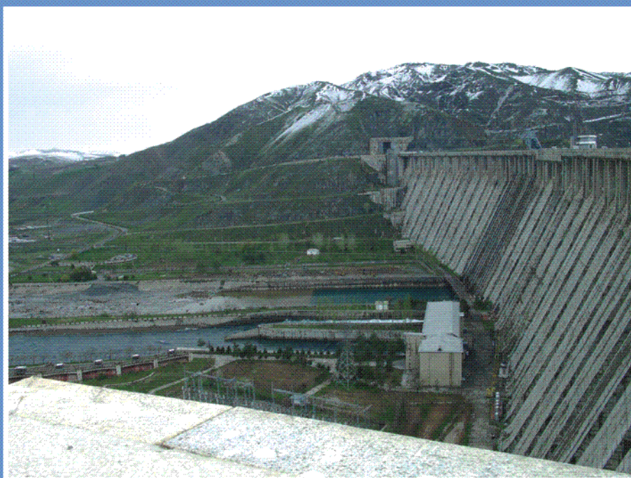
Рис. 16. Плотина Андижанского гидроузла на реке Карадарья, Узбекистан (высота плотины - 121 м; объем водохранилища - 1900 млн.м 3 )
