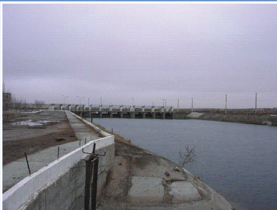
Рис. 14. Огузханский гидроузел на Каракум-реке, Туркменистан (высота плотины - 15 м; объем водохранилища - 700 млн.м 3 )
