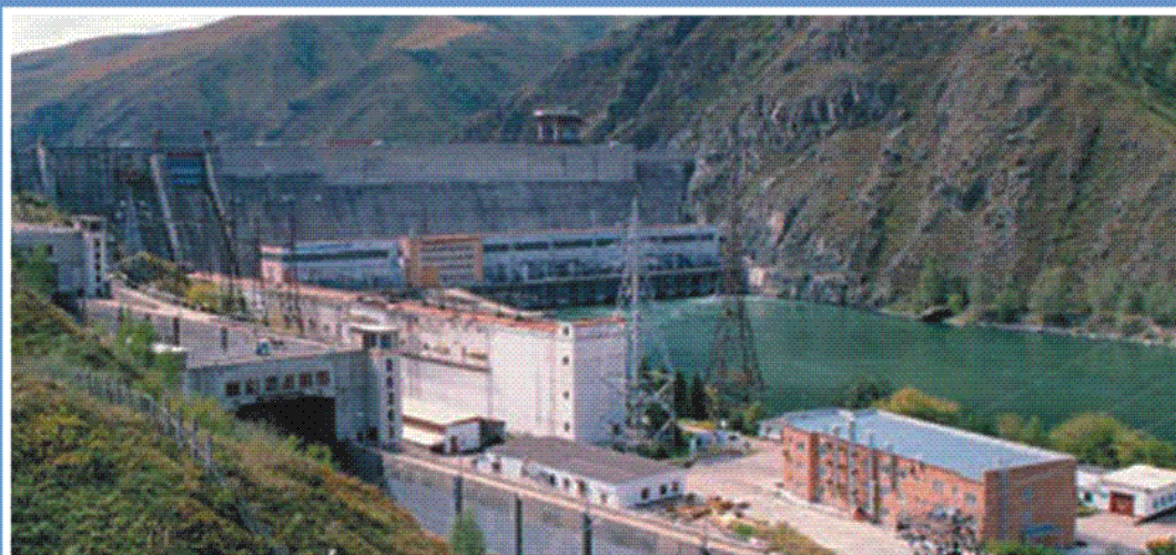
Рис. 6. Плотина Бухтарминского гидроузла на реке Иртыш, Казахстан (высота плотины - 90 м; объем водохранилища - 49800 млн.м 3 )
