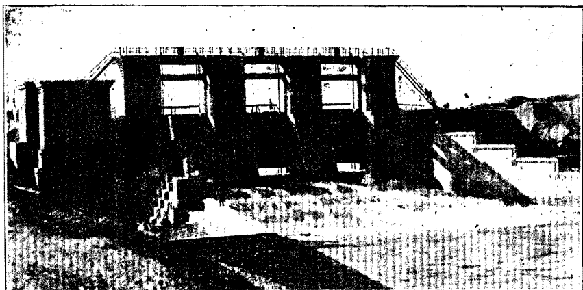
Фиг. 37. Султанбентская плотина съ низовой стороны.
