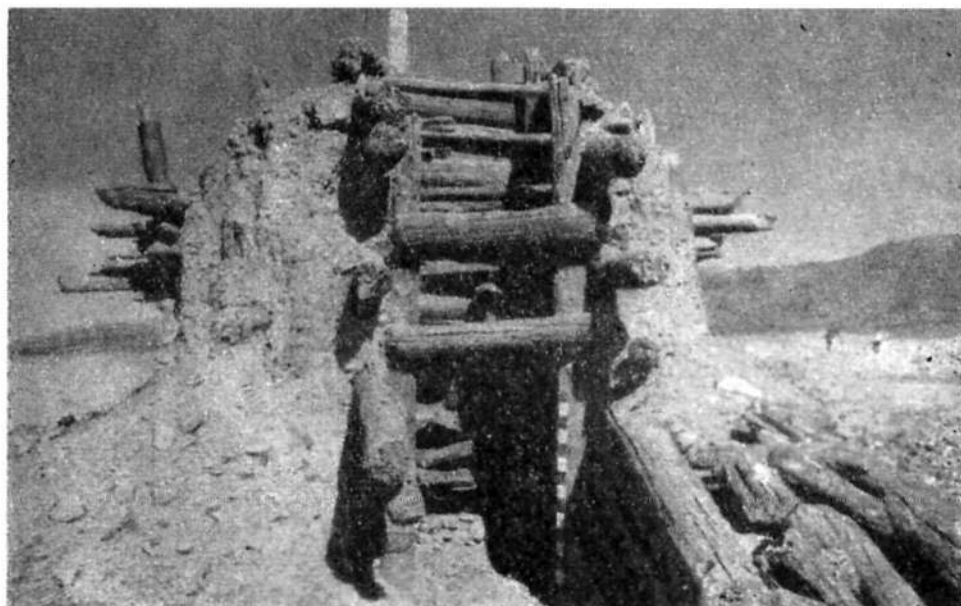
Рис. 42. Восточный фасад — вход в усыпальницу.
