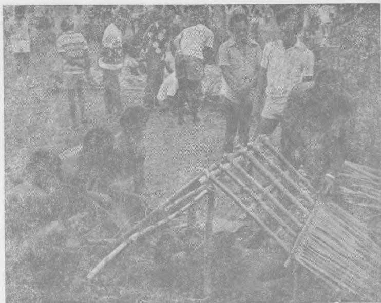
Рис. 4. Способ покрытия хижин пальмовыми листьями
