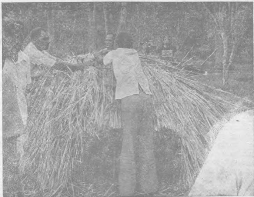
Рис. 6. Покрытие тростником каркаса крыши хижины с Тонгоа
