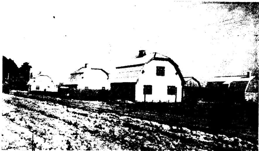
Рис. 8. Улица в новом поселке сельхозартели «Лачплесис» Огрского р-на с построенными на ней домами из крупнопористого бетона
